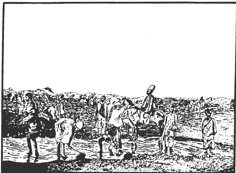
شکل ۱۰۸- کارگران در حال احداث بند سیستان، ترسیم از روی عکسی از گانگاسینگ ۱۹۰۵ م
