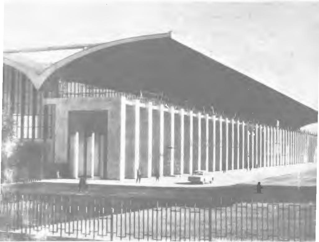
ایستگاه راه آهن
