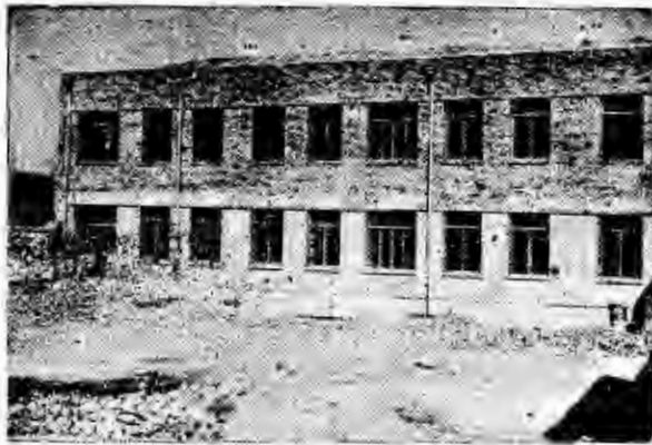
نمای ساختمان دبستان
