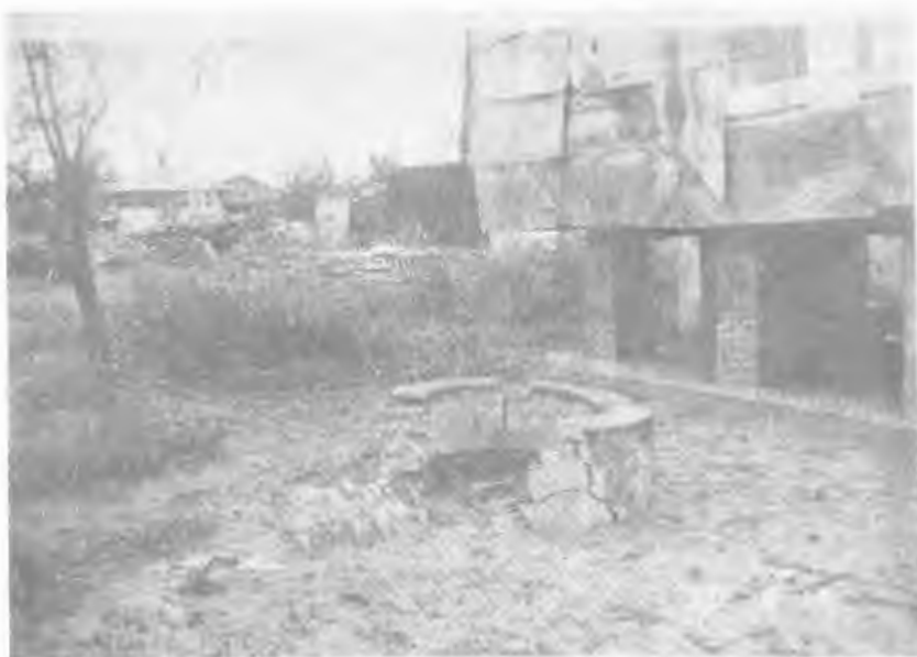
شکل ۱۵ - چاه پر شده با ماسه در آستانه
