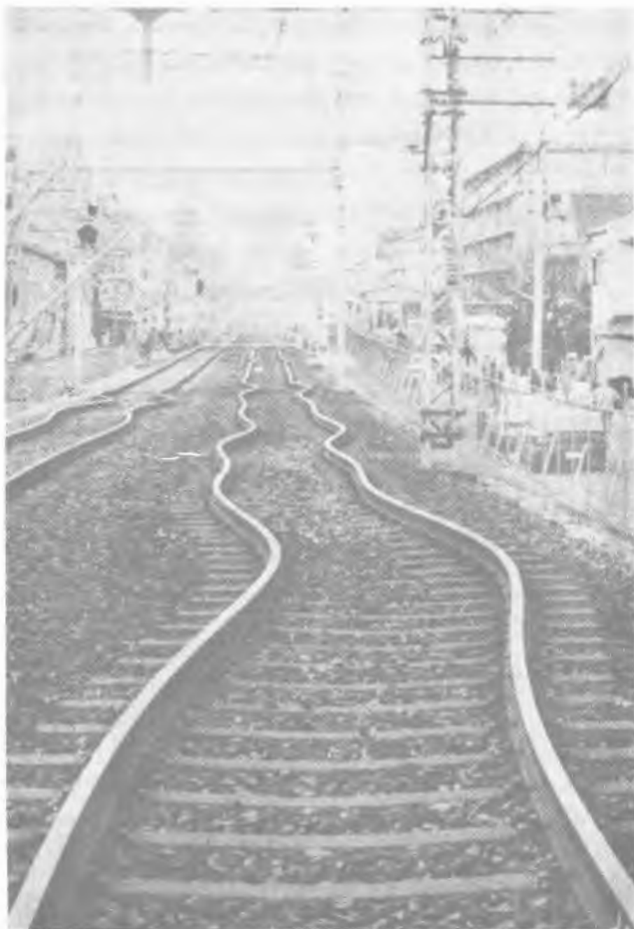
شکل ۲ - مسیرهای انحرافی یافته راه آهن هانکیو در کوبه
