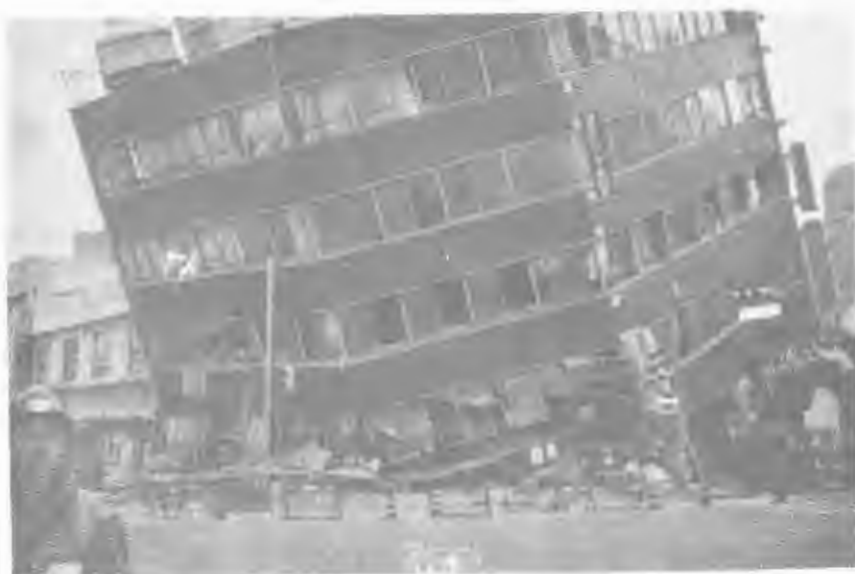
شکل ۶ - فرو ریزی یک ساختمان با پلان نامتقارن
