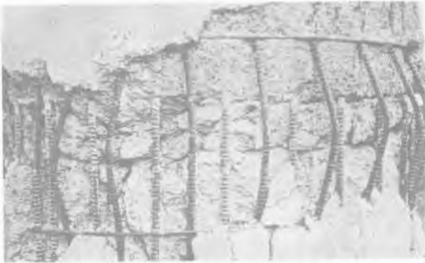
عکس شماره ۱۲- نمونه‌ای از بریده شدن جوش آرماتور طولی در ستون بتن آرمه
