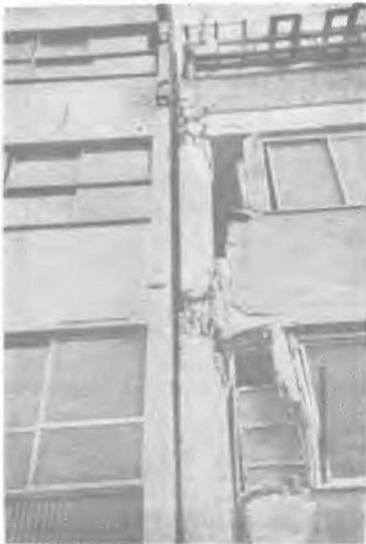
عکس شماره ۱۳- خسارت ناشی از بریده شدن جوش آرماتورهای طولی ستون بتن آرمه
