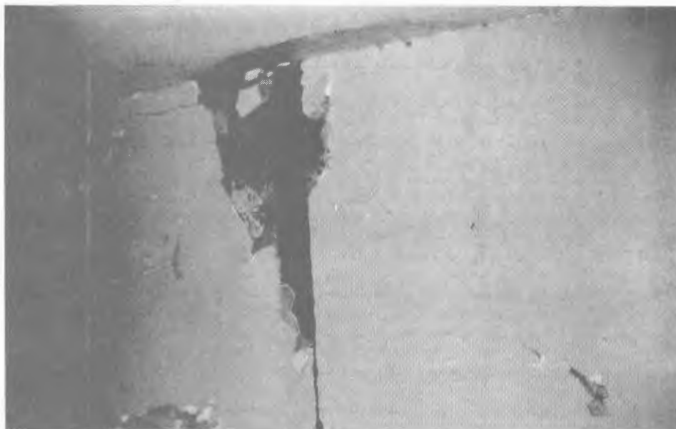
تصویر شماره ۲۰- خرد شدن دیوار در گوشه قاب در مهمانسرای سیمان خزر
