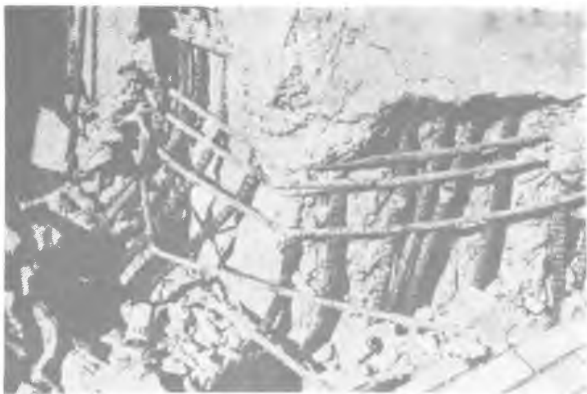
عکس شماره ۷- مهار ضعیف خاموت‌هایی که با خم ۹۰ درجه بسته شده‌اند در ستون بتن‌آرمه
