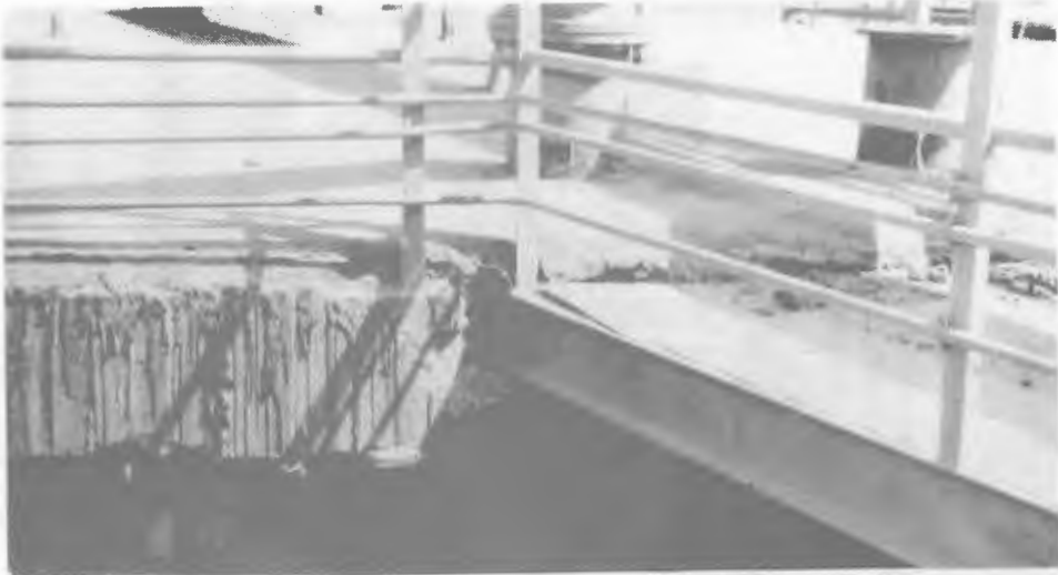
تصویر شماره ۱۴- آسیب دیدن و خرد شدن بتن در محل اتکای تیر فلزی راهروی بین دوسیلوی سپهان
