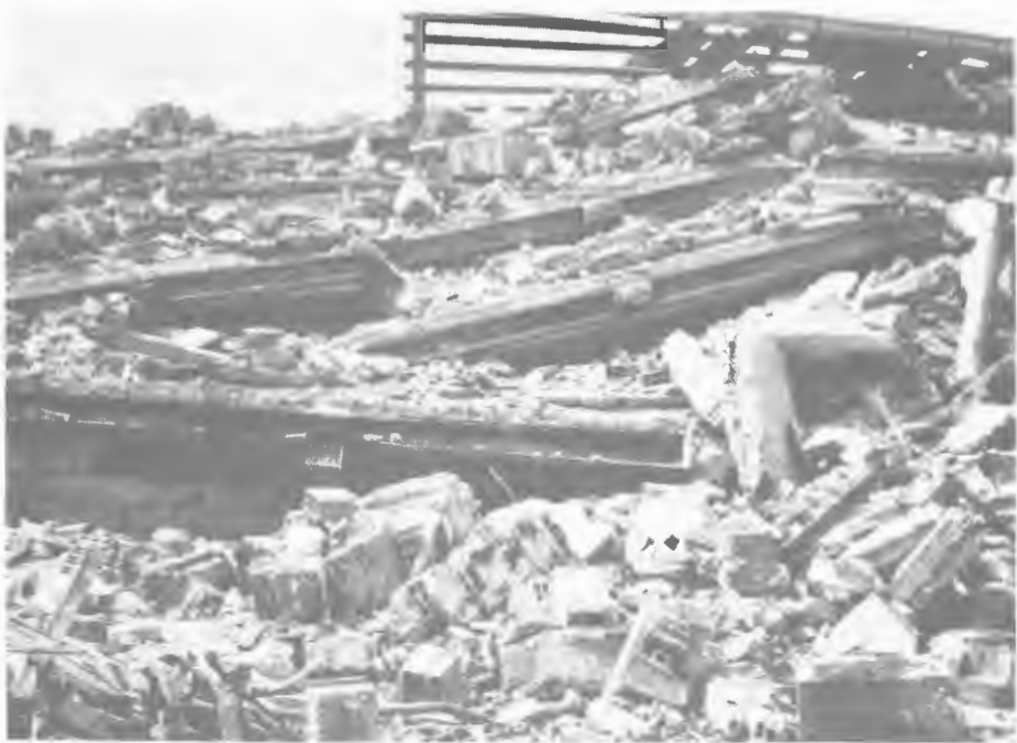
شکل ۹- آوارهای به جا مانده از یک ساختمان مسکونی ۴ طبقه با اسکلت فلزی در شهر رشت
