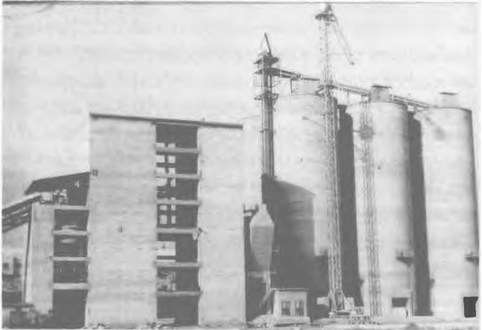
تصویر شماره ۸- آسیاب سیمان و سیلوهای سیمان کارخانه سیمان خزر پس از زلزله
