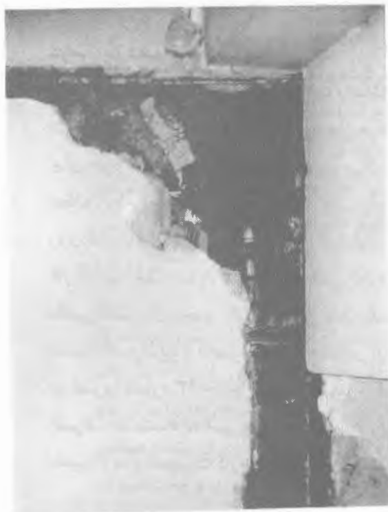
تصویر شماره ۲۰- خرد شدن دیوار در گوشه قاب در مهمانسرای سیمان خزر
