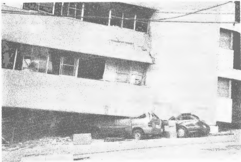
عکس شماره ۲- خرابی در طبقه نرم زیرین
