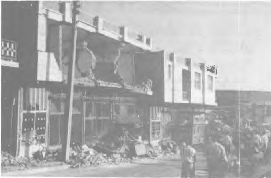
شکل ۶- ساختمان اسکلت فلزی در شهر منجیل
