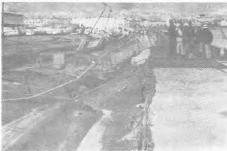
شکل ۱۰ - جابجایی دیوار حفاظ دریا و آسیب‌های وارده همراه آن (مسیر ونگان)
