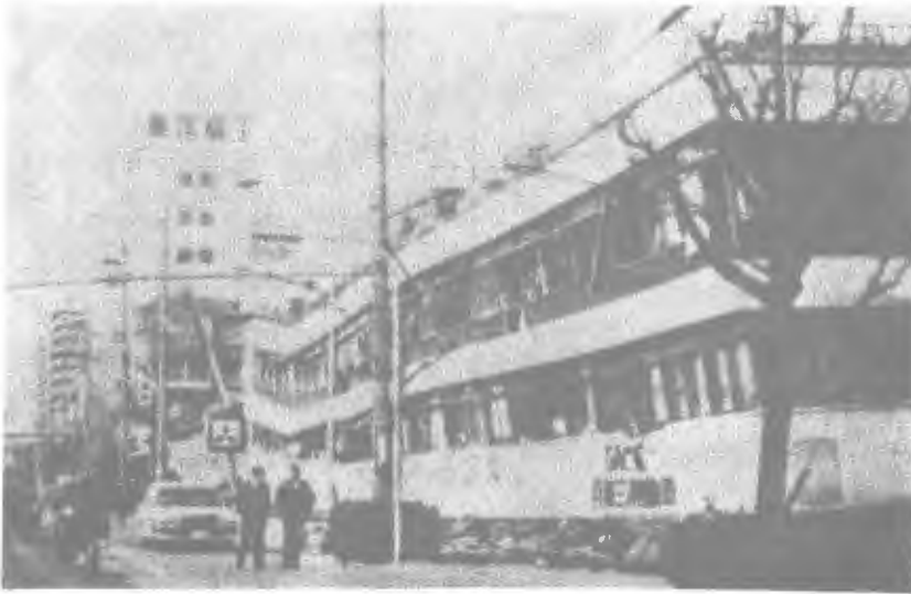
هنکس شماره ۳۰ خرابی در طبقه نرم زیرین
