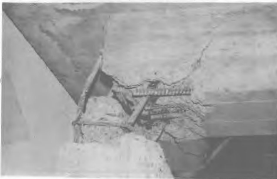
تصویر شماره ۳- گره فوقانی ستون گوشه داخلی راه پله
