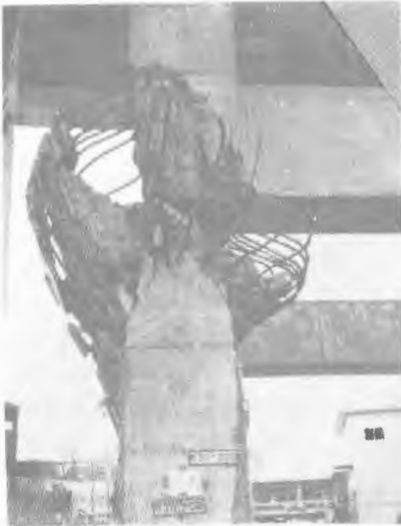
عکس شماره ۱۱- نمونه‌ای از خسارت در ستون بتن آرمه خط شین‌کانسن (ShinKansen)
