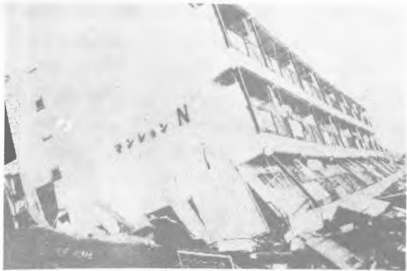
عکس شماره ۱- خرابی در طبقه نرم زیرین
