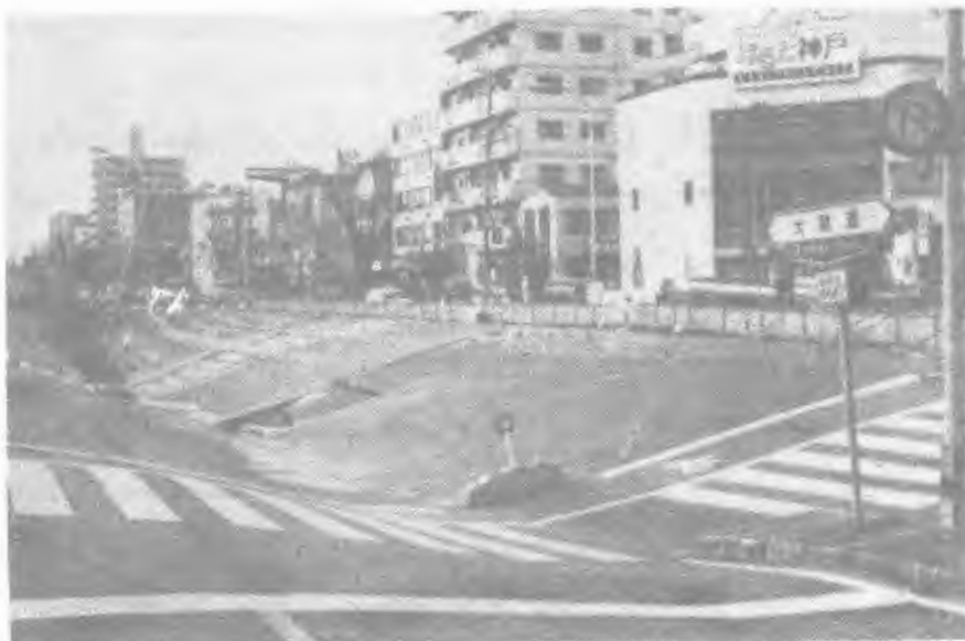
شکل ۳ - فرونشست خیابان به علت تخریب ستون‌ها در ایستگاه زیرزمینی مترو (ایستگاه دای کای)
