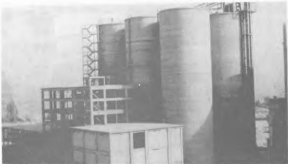
تصویر شماره ۱۲ - سیلوهای سیمان، ساختمان بارگیرخانه و موقعیت برج پله فلزی آسیب دیده
