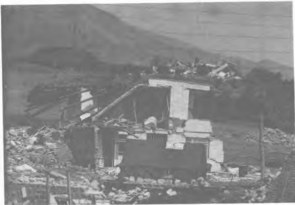
شکل ۲- یکی از ساختمان‌های سنتی شهر منجیل که خسارت شدیدی از زلزله دیده است.
