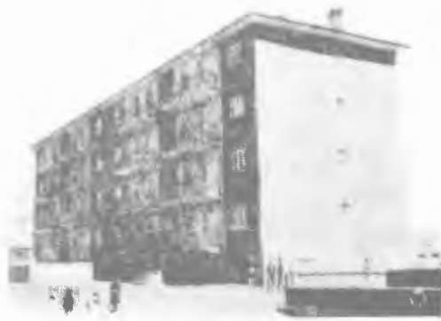
تصویر ۴ - آپارتمان قدیمی
