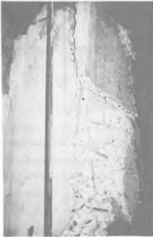
تصویر شماره ۱۴- آسیب دیدن و خرد شدن بتن در محل اتکای تیر فلزی راهروی بین دوسیلوی سپهان
