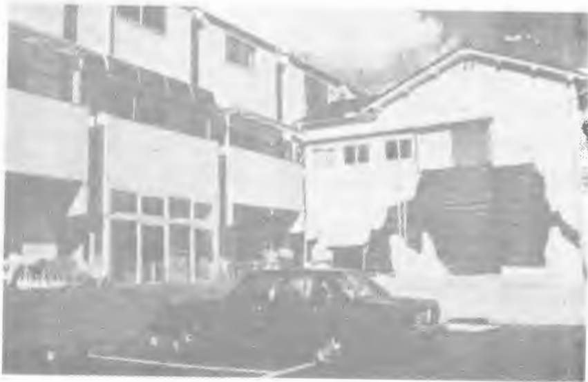
شکل ۱۴ - خانه چوبی جدید متداول در ژاپن (سمت چپ)، نوهی که بدون آسیب دیدگی آشکارتاکی مانده است.
