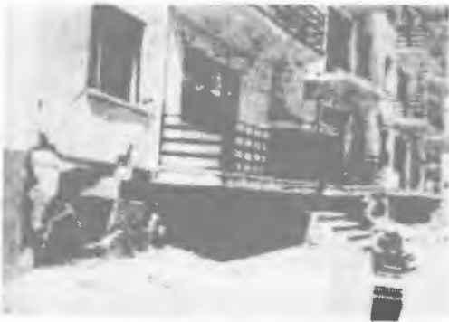
تصویر ۶ - دید نزدیک از تصویر ۵ گسیختگی در تراز زیر زمین
