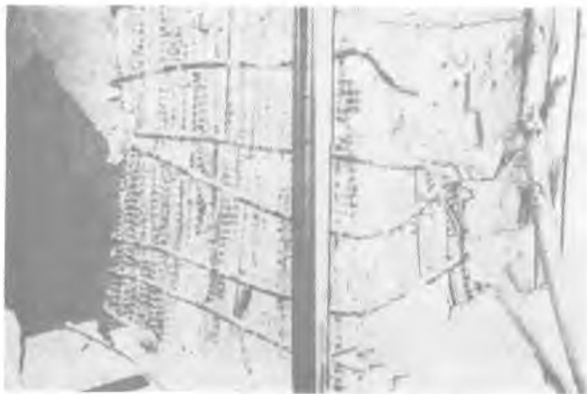
عکس شماره ۸- خرابی ستون ناشی از تراکم آرماتورهای طولی و فقدان خاموت‌های مستقل
