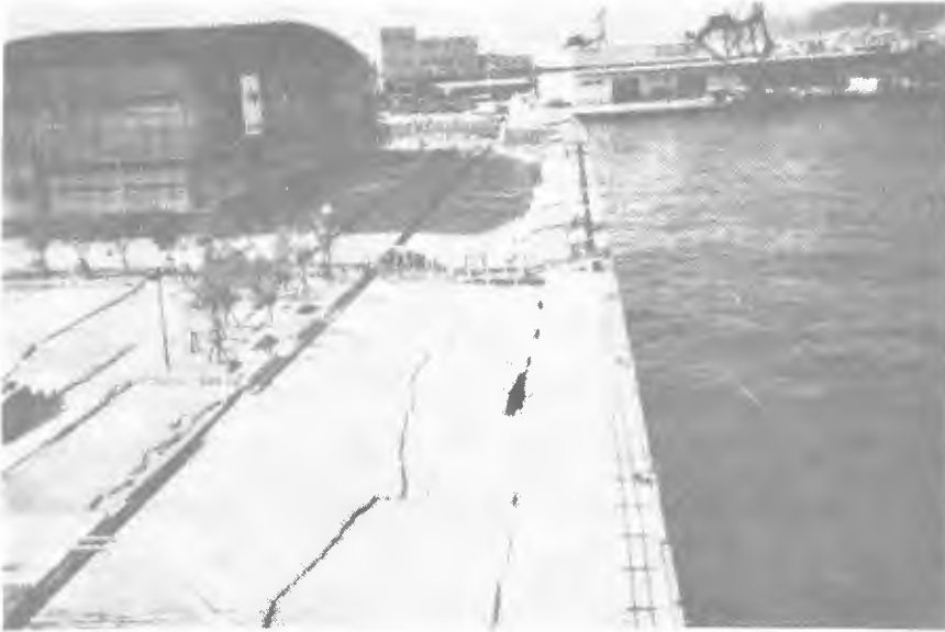
شکل ۱۱ - تخریب دیوار و حرکت جانبی زمین (جزیره رگوه)
