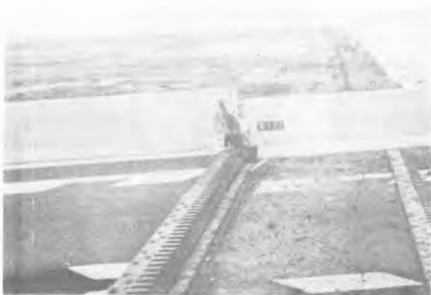
شکل ۴ - نمونه‌ای از آسیب دیدگی اتصال بزرگراه و نگان
