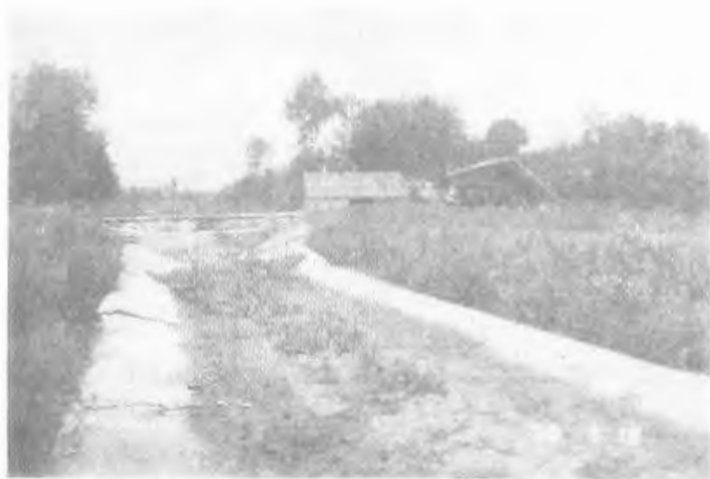
شکل ۲۱ - کانال آب بتنی پرشده با ماسه در منطقه آبگونه شده بین آستانه و رودبند
