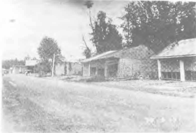
شکل ۱۹ - کج شدن خانه‌ها به طرف کانال در رودبند
