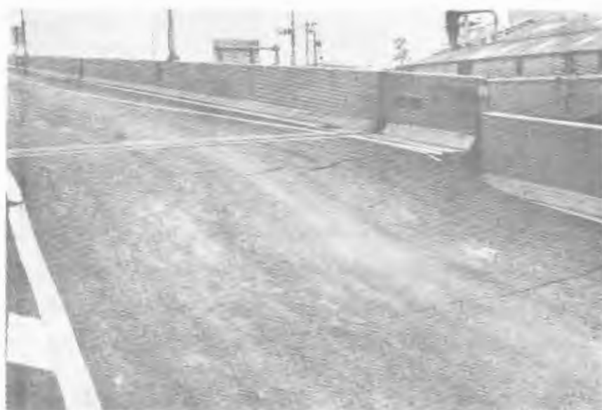
شکل ۵ - نمونه‌ای از نشست یکی از دهانه‌های ورودی بزرگراه و نگان
