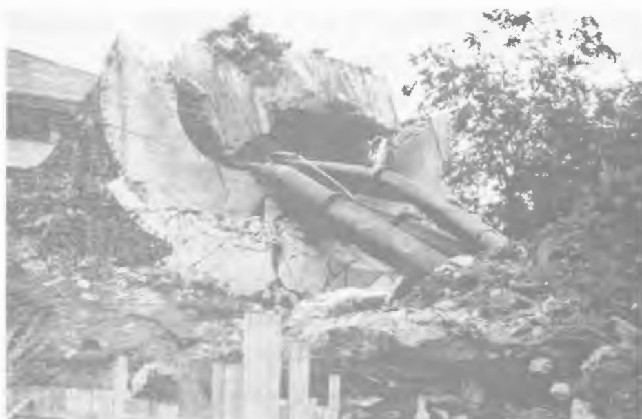
تصویر ۸- انهدام برج آب بتنی ۱۵۰۰ متر مکعبی شهر رشت
