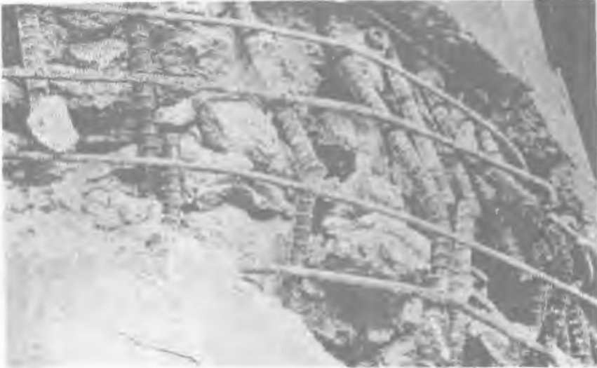
عکس شماره ۱۳- خسارت ناشی از بریده شدن جوش آرماتورهای طولی ستون بتن آرمه
