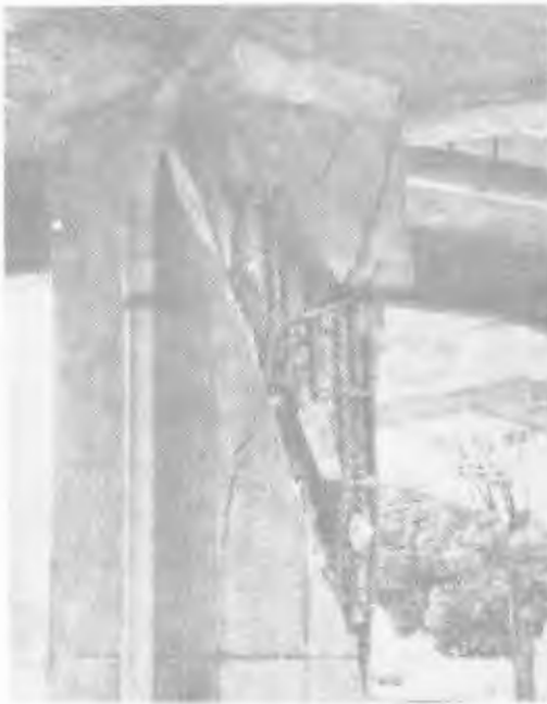
عکس شماره ۱۰- نمونه‌ای از خسارت در ستون بتن‌آرمه خط آهن هان‌کیو (Han-Kyo)
