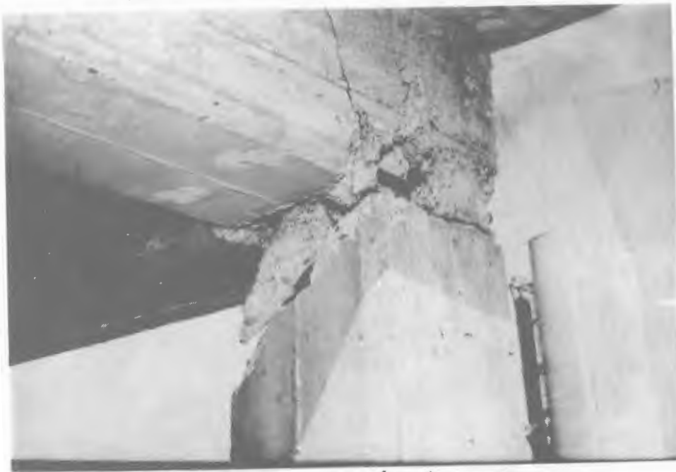
تصویر شماره ۵- گره فوقانی ستون کناری راهپله
