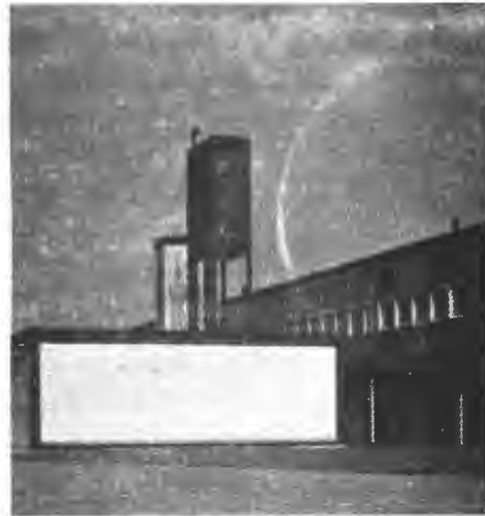
ساختمان دبیرستان در هانسانتون اثر پیتر والیسون اسمیت، نورفولک، ۵۴ - ۱۹۴۹، نمونه مشخصه سبک معماری زیبره‌کاری نوین، به برج مخزن آب که آشکارا نمایش داده شده توجه کنید.
