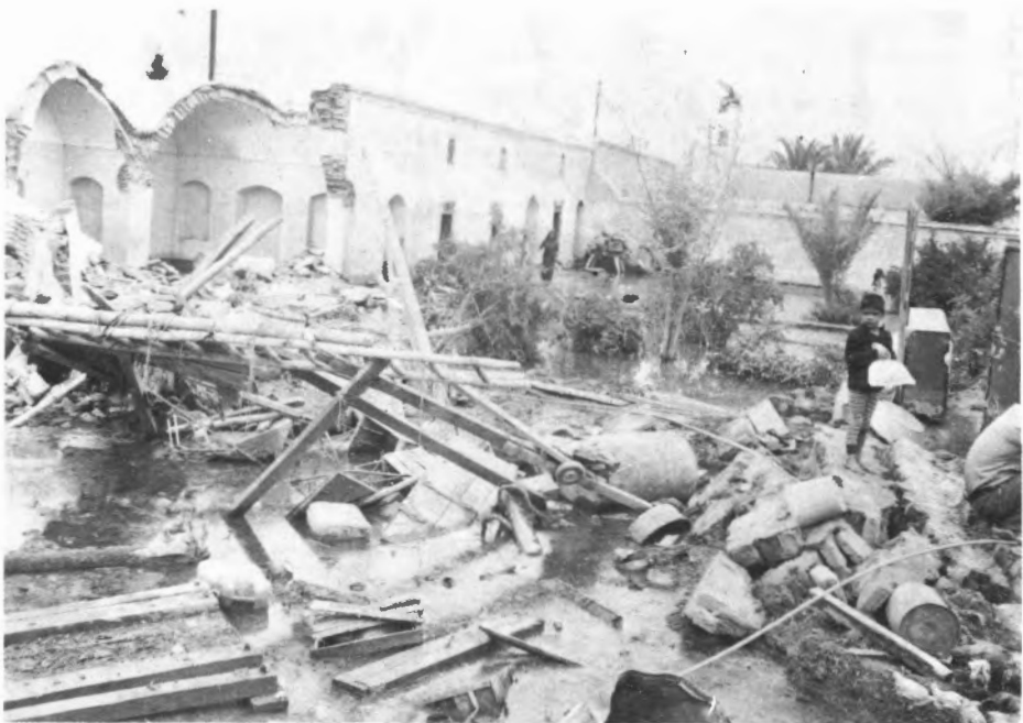
منازل تخریب شده در اثر جاری شدن سیل خردادماه ۱۳۶۶، زاهدان
