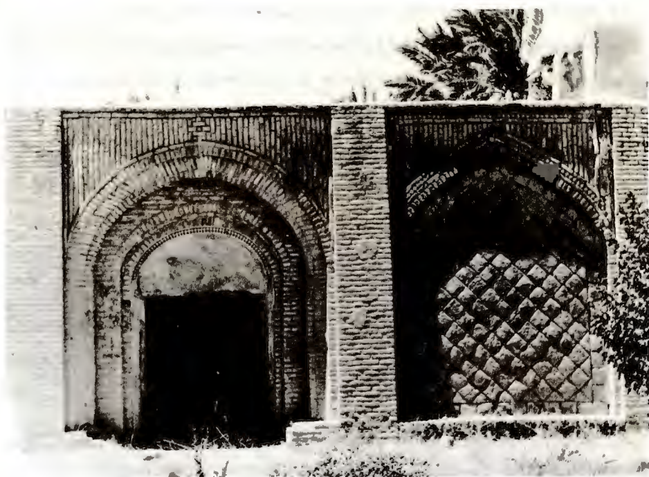
نمای ساختمان تاریخی واقع در پارک کیمه، رامهرمز
