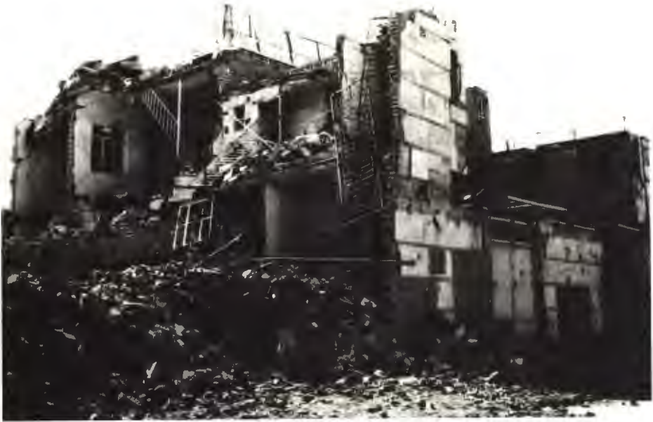
منزل آسیب دیده، خرمشهر
