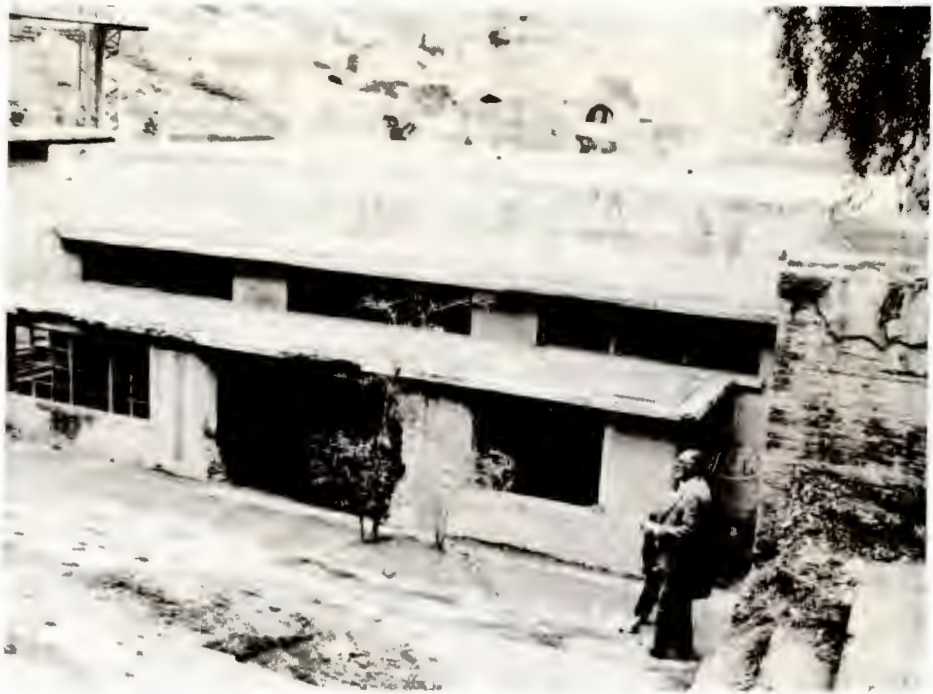
ساختمان قدیم کارخانه برق شوشتر
