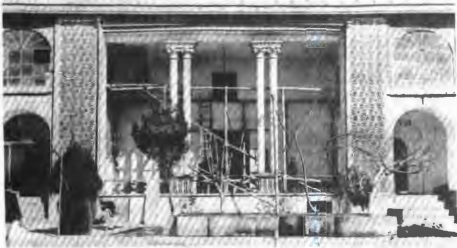
نمای جنوبی بقعه پیغمبریه پیش از تعمیرات
