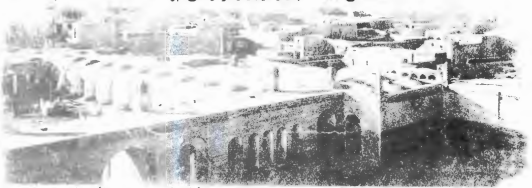
نمای قسمتی از راهدارخانه و کاروانسرای سعدالسلطنه و بقعه شاهزاده حسین و محله دباغان
