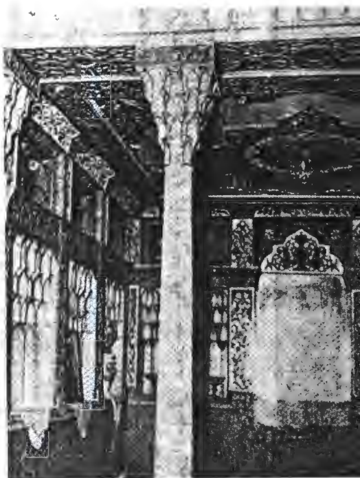
عکس قسمتی از تالار خانه تقوی در قزوین و طرز بنای تاقچه‌ها و رف‌ها و نقاشی‌های آن و چگونگی در و آئینه و کیلویی‌ها و ازاره آن
