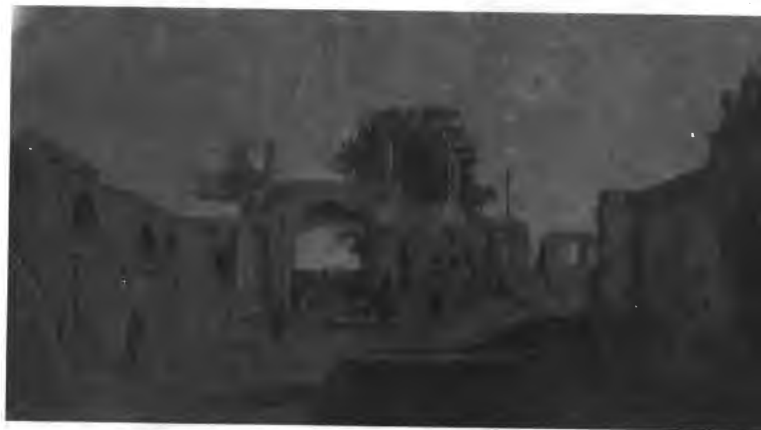
نمای دروازه پنبه ريسه از داخل شهر
