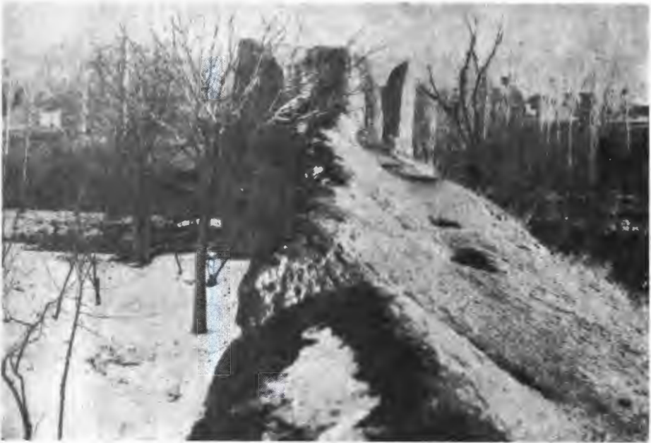
قسمتی از حصار گلی قزوین واقع در شرق دروازه درب کوشک که از داخل خاکریزی شده
