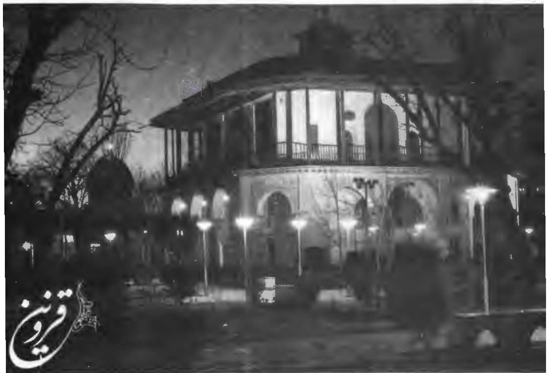
نمای شرقی و جنوبی عمارت کلاه فرنگی (موزه فعلی و گنبد بقعه پیغمبریه)
