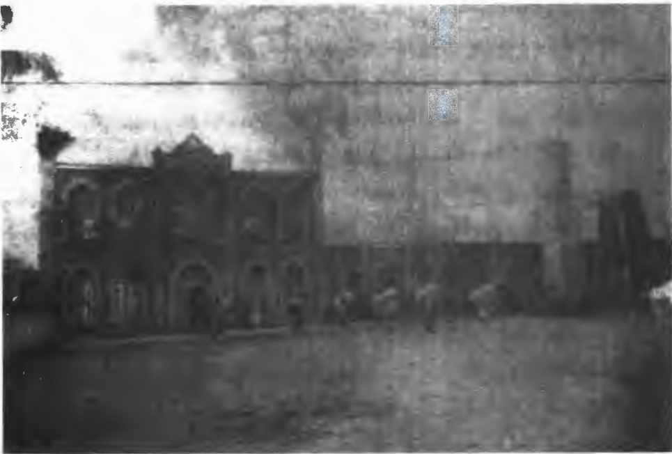
تصویر کارخانه آرد ابریشمی یا (آرد ایران) که در بیرون دروازه شیخ آباد در جانب شرقی خیابان سعدی بنا شده بود
