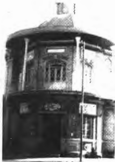
عمارت پست و تلگراف در مدخل شرقی خیابان پیغمبریه
