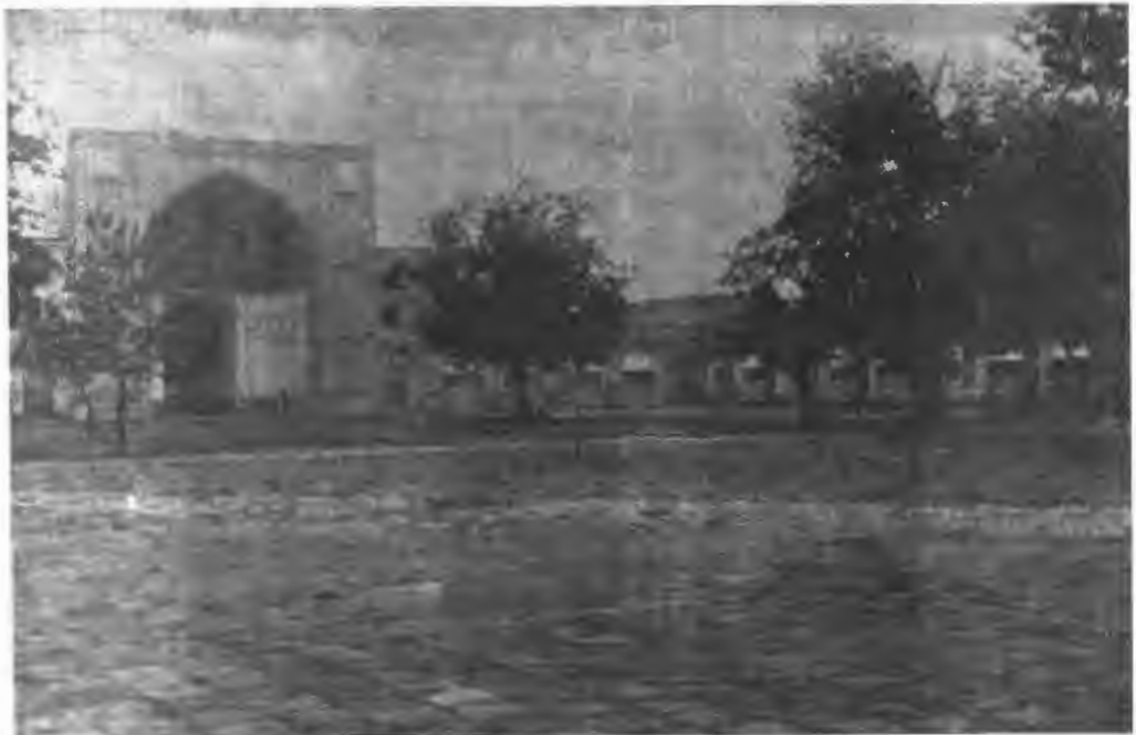
قسمتی از ساختمان جنوبی و غربی و حیاط مسجد شاه قزوین
