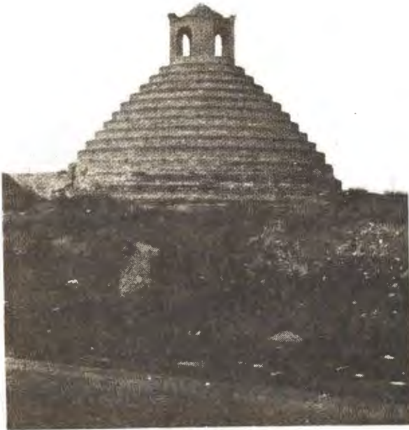
يك آب‌انبار قدیمی بین راه گرمسار و ایوانکی. آب همیشه مسئله عمده روستاهای حاشیه کویر بوده است و آب‌انبار وسیله معمول برای جمع آوری و استفاده از آب باران.
